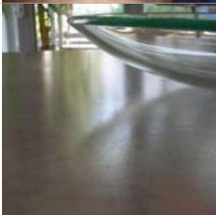
Gewachste Beton-Oberflächen zeichnen sich durch eine seidenglanzende Patina und angenehme Haptik aus. Der Wachs auftrag bildet eine hauchdünne Schutzschicht, lässt Wasser vorübergehend abperlen und ein Schutz vor Verschmutzung ist weitgehend gewährleistet.
